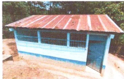
Foto 2: Módulo 1: Se puede apreciar que la cubierta de lámina están deterioradas por el paso del tiempo.
