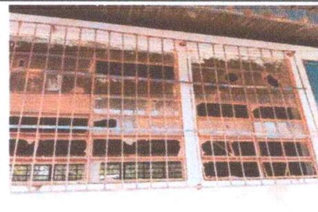
Foto 6: Las ventanas se encuentran deterioradas requiere de sustitución de vidrios y de mantenimiento de balcones.
