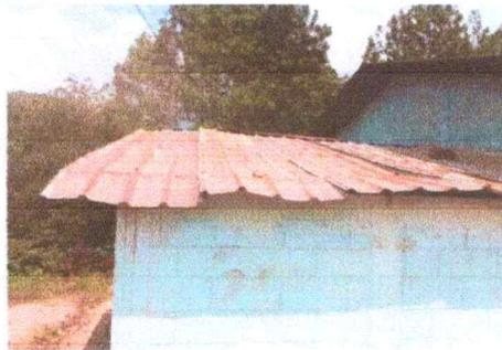
Foto 3: La cubierta de lámina de la cocina, con corrosión y en mal estado que requiere sustitución.
