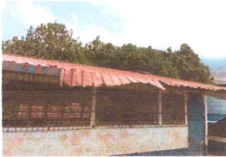
Foto 1: Módulo 2: Las láminas se encuentran mal estado que ameritan sustitución.
