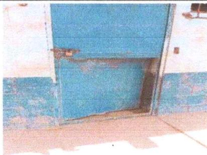
Foto 5: Las puertas con alto grado de corrosión, en mal estado que amerita mantenimiento y sustitución.
